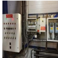
Рис.6 Щиты автоматизации и управления с частотными преобразователями
