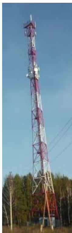
Рис. 1. – Вышка сотовой связи, имеющая односторонний крен
