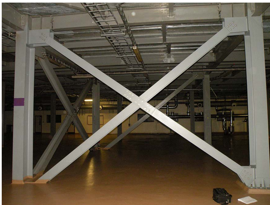
Рис. 3. – Здание производственного корпуса. Стальной рамный каркас и крестообразные связи в четырехэтажной части здания.
