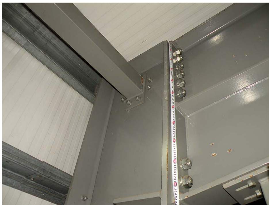
Рис. 4. Склад готовой продукции. Узел рамного каркаса здания.
