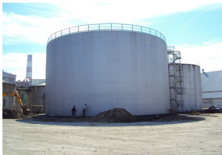
Рис. 1. – Общий вид объекта
